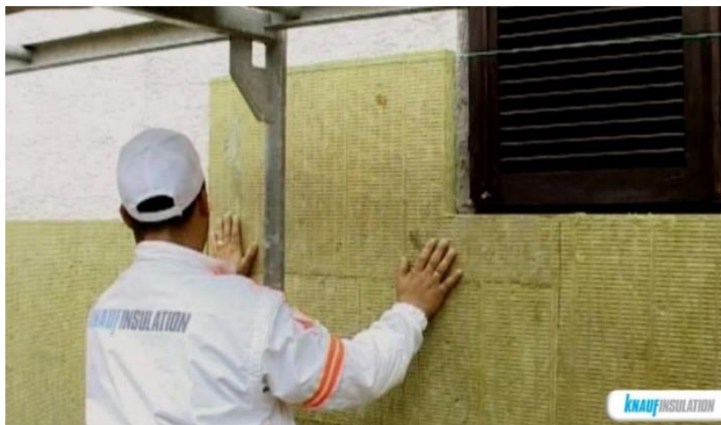
3. ábra. A külső fal hőszigetelése 3
