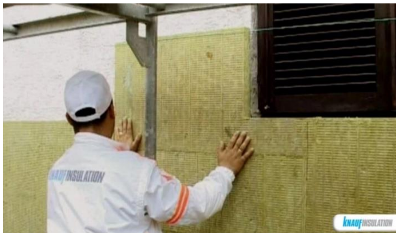
Slika 3.1. Toplinska izolacija vanjskog zida 3
